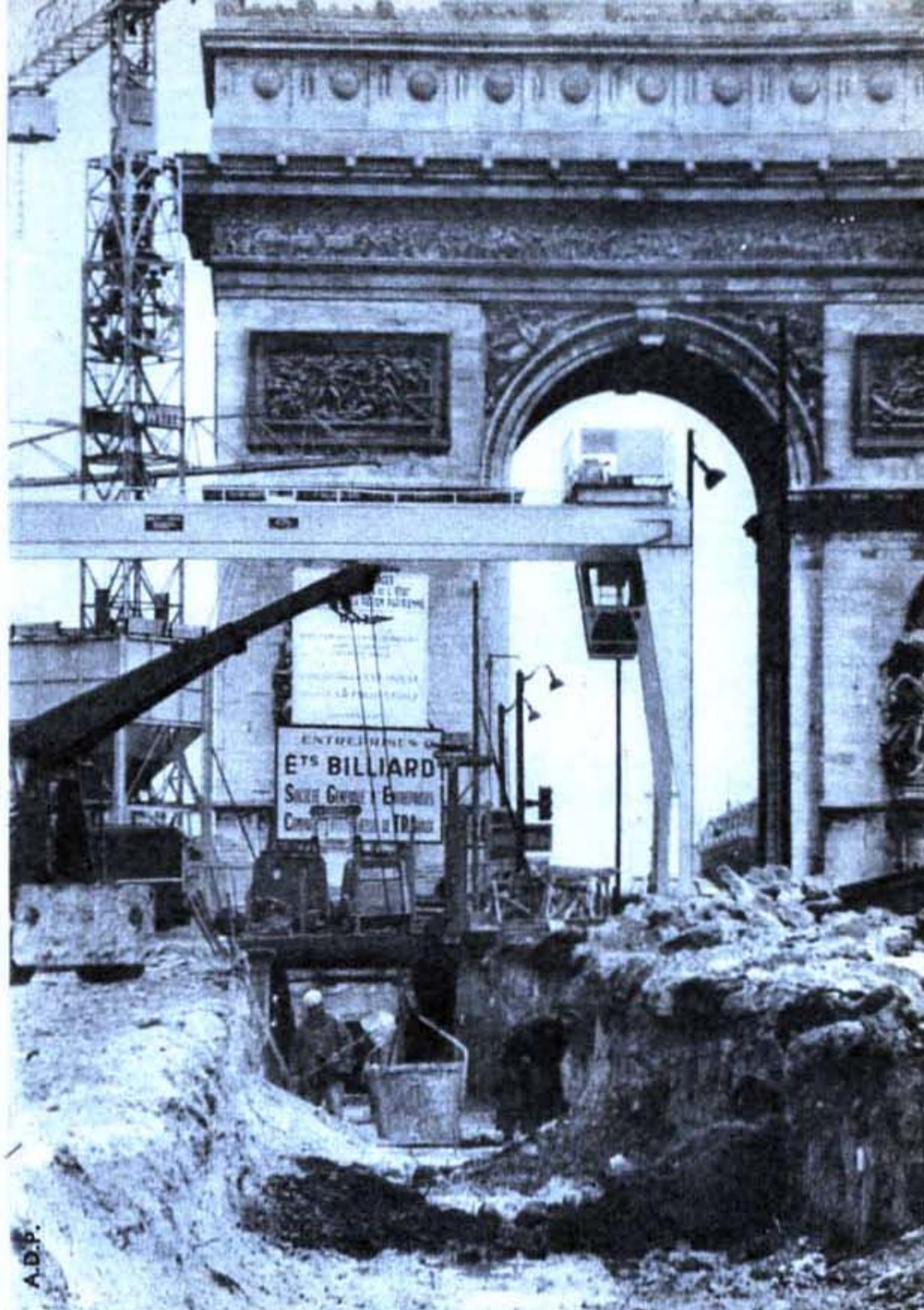
En pleins Champs-Élysées, au pied du célèbre Arc de Triomphe, des travaux de forage se poursuivent sans arrêt : c'est le chantier du « métro-express régional », un train qui conduira à grande vitesse, sous terre, du centre de Paris à sa banlieue.
