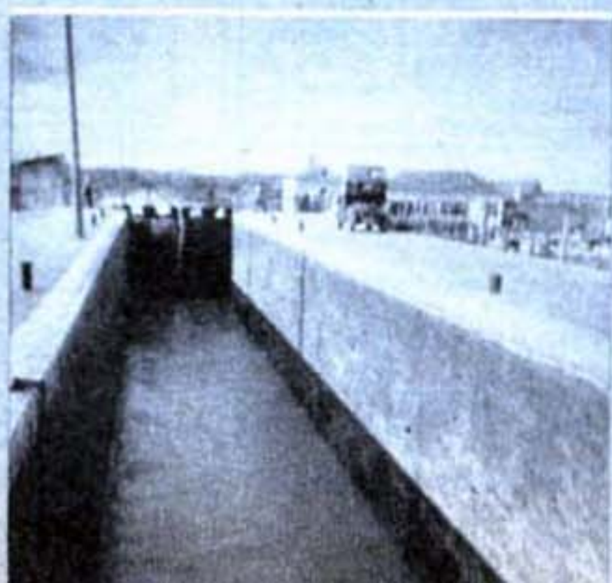
La péniche peut alors passer dans l'écluse n° 2 (photo 4). On ferme la 2 e porte et l'éclusier ouvre les vannes de la porte 3 pour mettre l'écluse n° 2 au niveau du canal.
