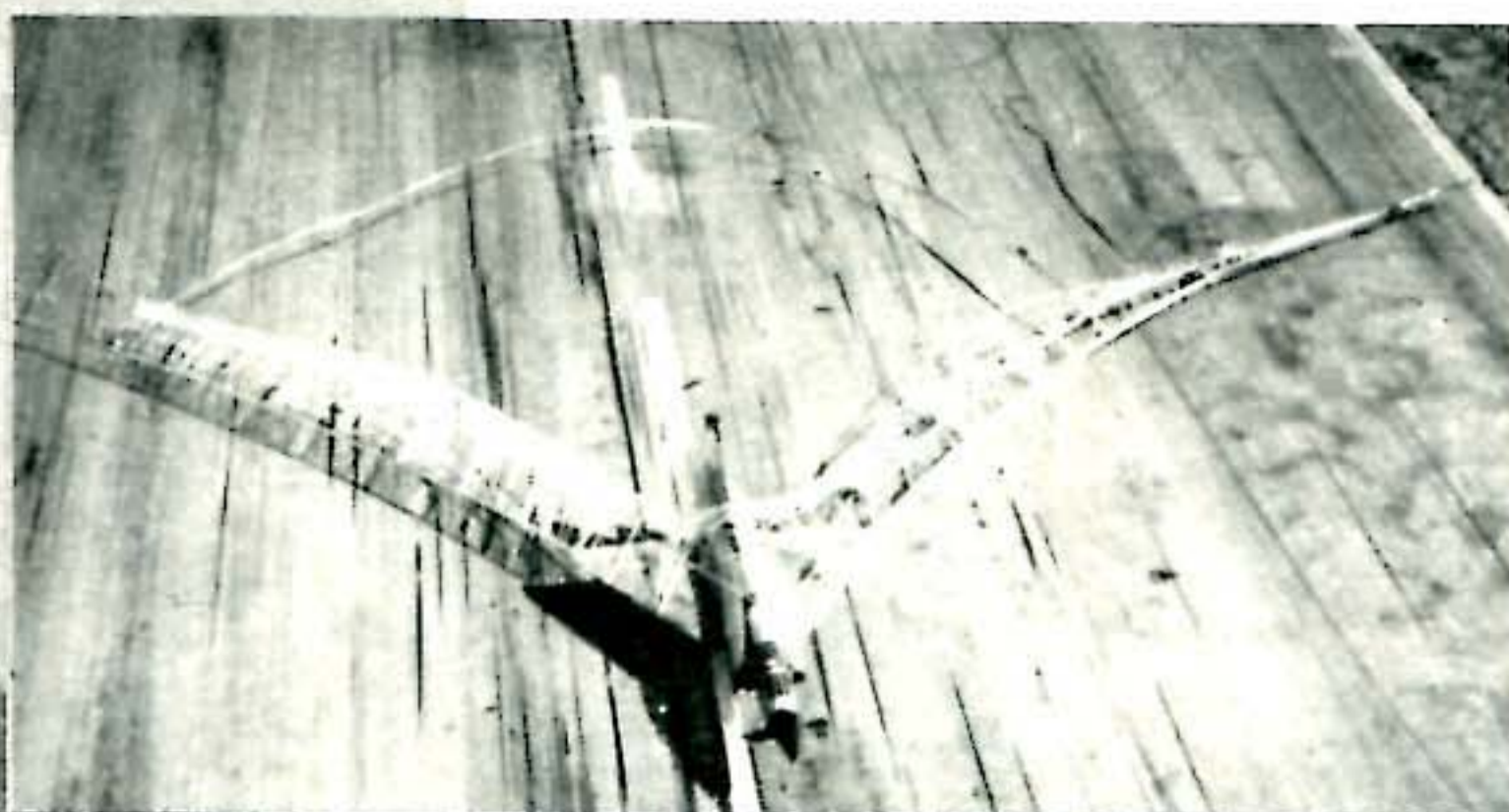
Voici, arrêté par le filet « Aératur » de la barrière d'arrêt française, un « Mirage III » de 12,5 t lancé à 325 km/h.
