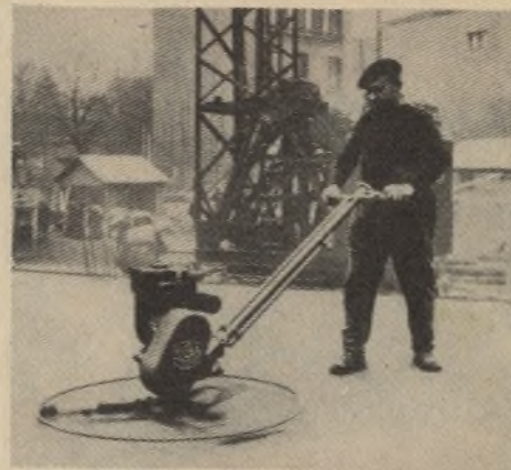
Talocheuse : le moteur entraîne une hélice horizontale qui polit le béton frais, évitant ainsi le pénible talochage à la main.
