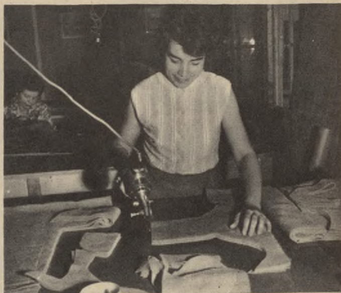
3. Ici, la machine est mise à contribution : les ciseaux électriques — une fine roue tournant à toute vitesse — permettent une coupe nette, rapide et de plusieurs épaisseurs à la fois.
